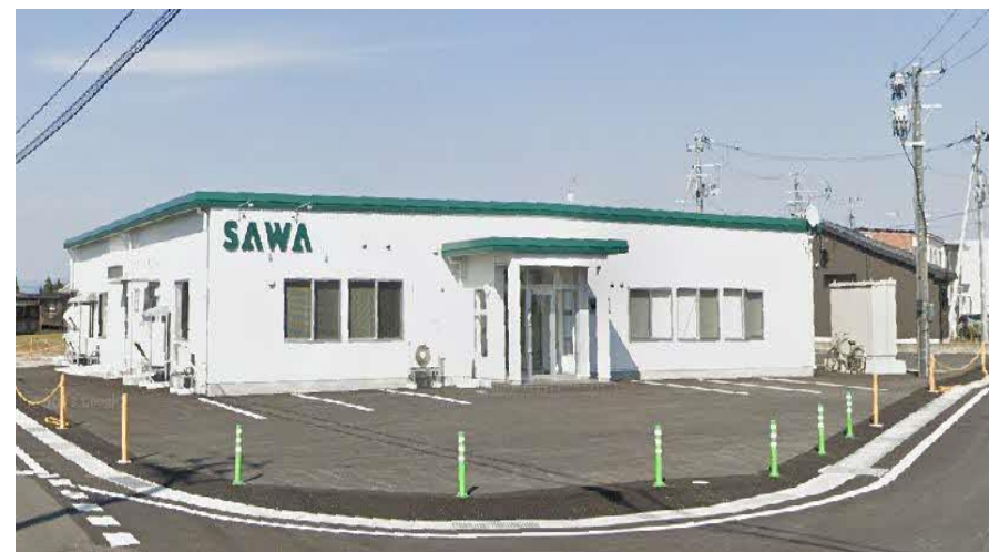
(3)卒業補助金を活用し、市内展開した株式会社SAWA様の新工場
