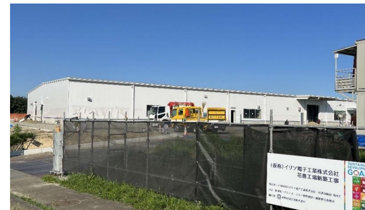
現在、市内で新たに建設しているイリソ電子工業(株)様の新工場建設工事の様子
